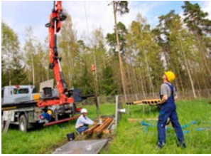
Frühjahrsputz im Tiefbrunnen Weidighaus
